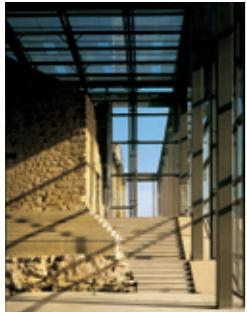
A Bougon, nous avons pris le parti d'implanter les niveaux bas du musée comme une cave dans le **sol calcaire**. Le niveau d'entrée du musée correspond à celui du fond de fouille, à quatre mètres environ en dessous du sol initial et le traitement architectural de ce niveau d'entrée en a renforcé le caractère calcaire par l'insertion de dalles calcaires, de tailles et de finitions diverses.
