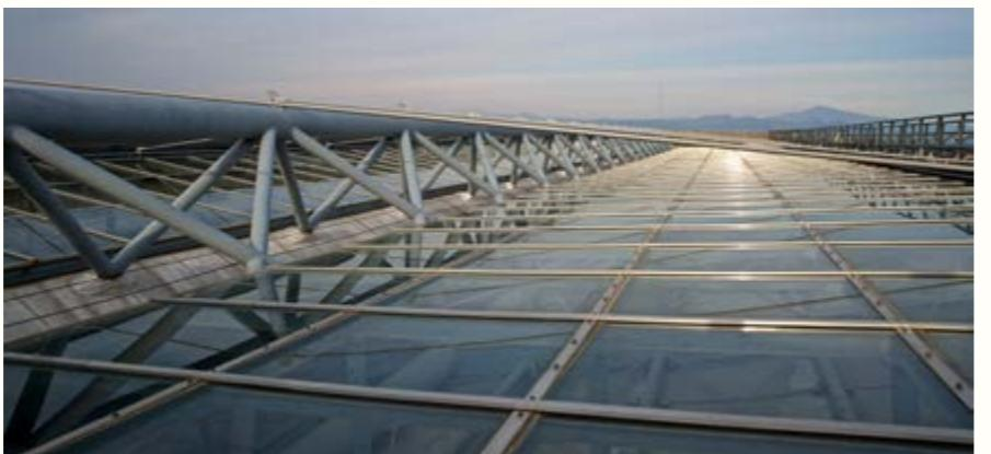
Composition de la façade du toit, comme une voile / The glass and steel roof structure acting like a veil
