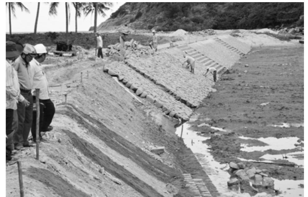
La création des quais des bords de rivière avec du granit local, 2012 / Constructing the embankment with local granite, 2012
