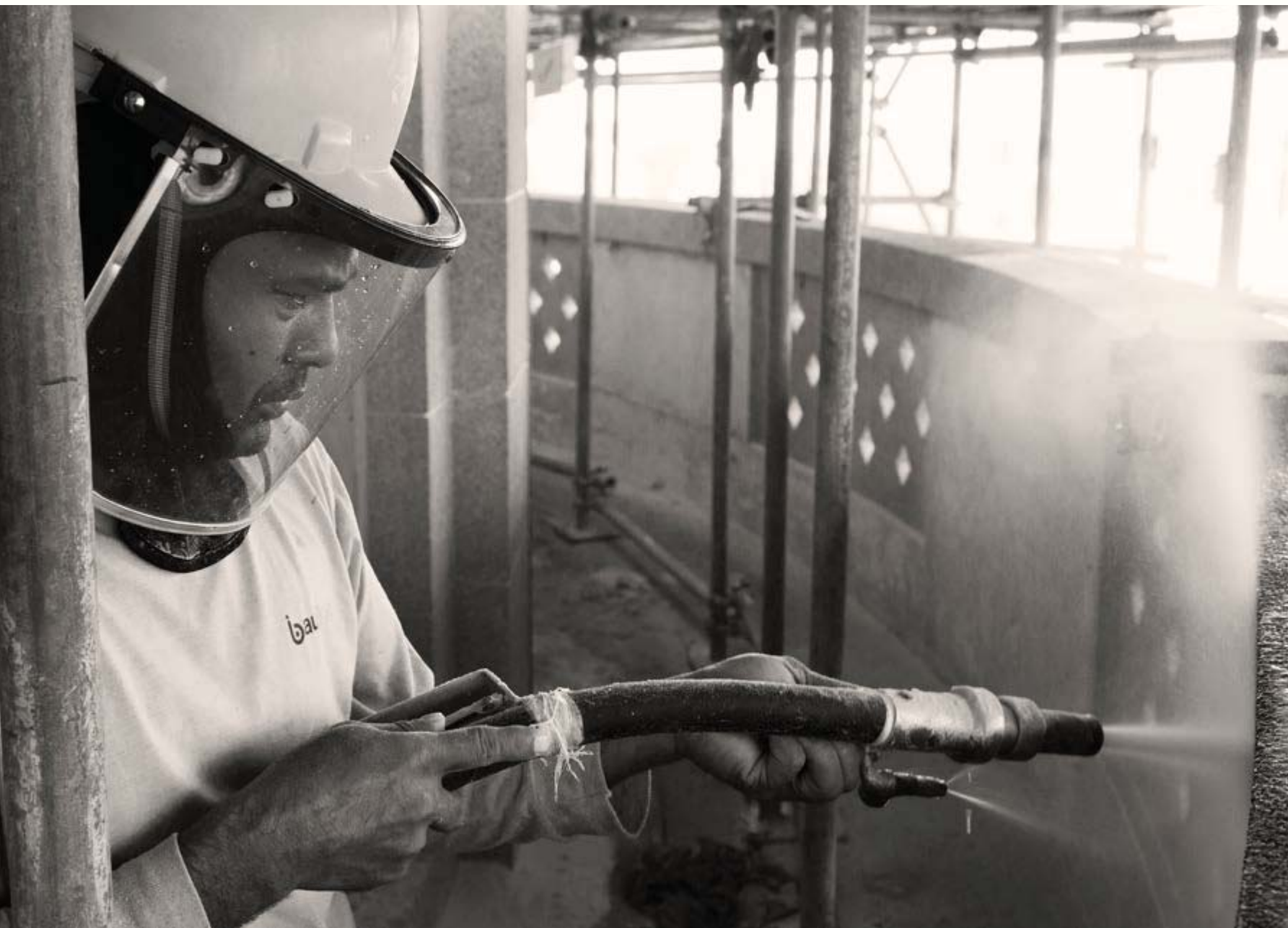
Nettoyage du béton granitique de la façade à l'eau, 2012 Jet-cleaning of the Shanghai plaster with water, 2012
